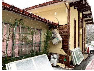
被災した輪島教会
