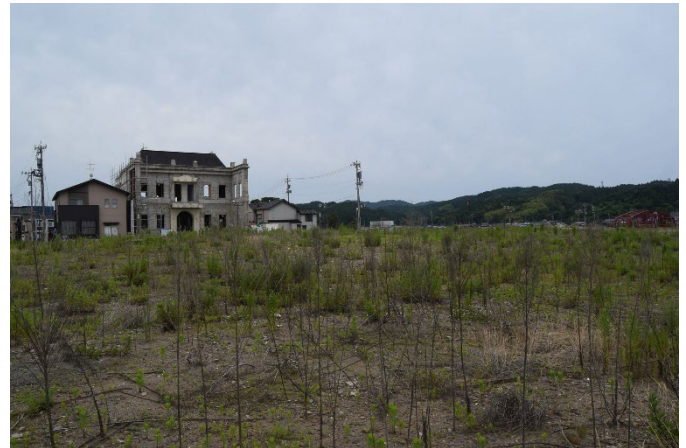
震災から2年半経過した輪島朝市の焼け跡
